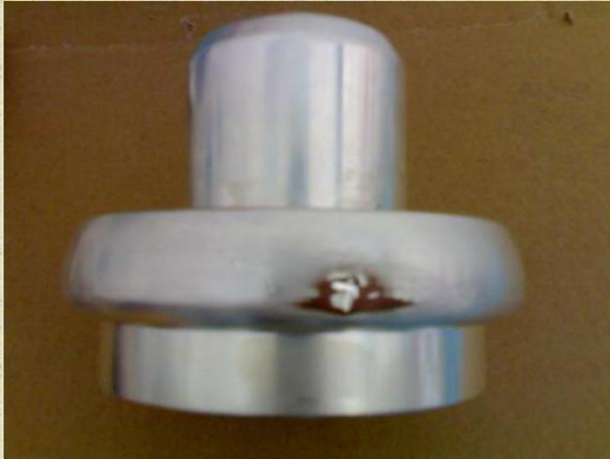
A相电缆GIS接头套管金属接插件屏蔽损伤处照片
