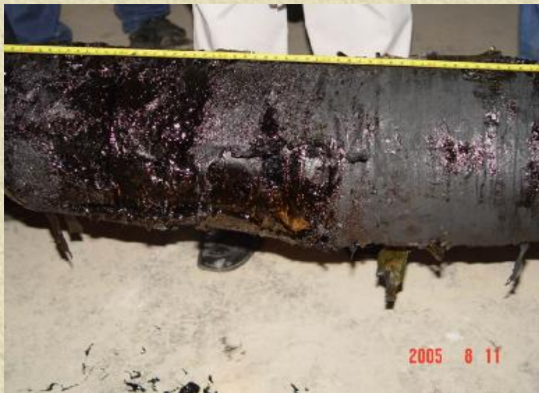
中间接头故障后图片
